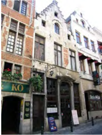
Rue des Chapeliers n°s 18-20 tiered gable
