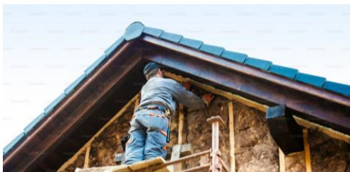
Pose d'une couche d'isolation thermique par l'extérieur (source : © Unsplash)
