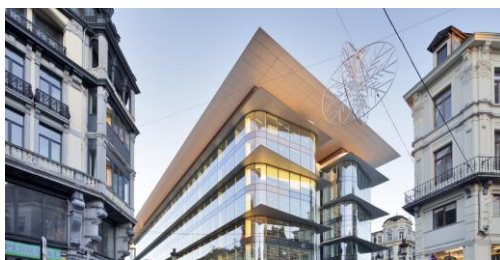
Brise-soleil & auvent au Centre administratif Brucity à Bruxelles, Belgique (source : b2ai.com)
