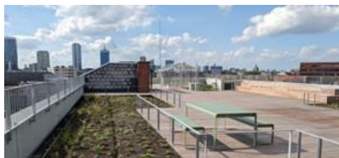
Toit de l'école Adolphe Max à Bruxelles, Belgique (source : construbel.be)
