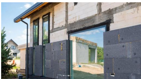
Pose du matériau d'isolation (source : stock d'images)
