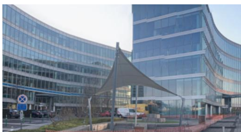
Structure de voile d'ombrage à Zaventem (source : google maps)
