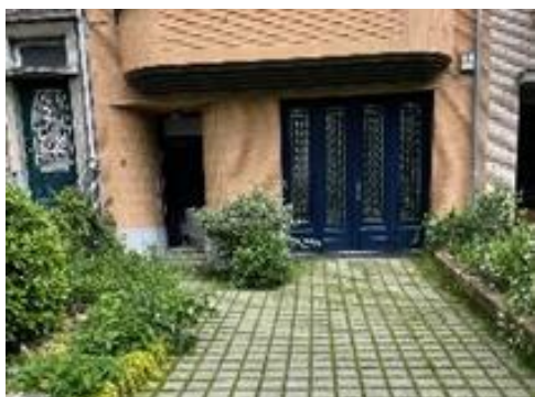
Maison unifamiliale à Laeken, Belgique (source : Ville de Bruxelles)
