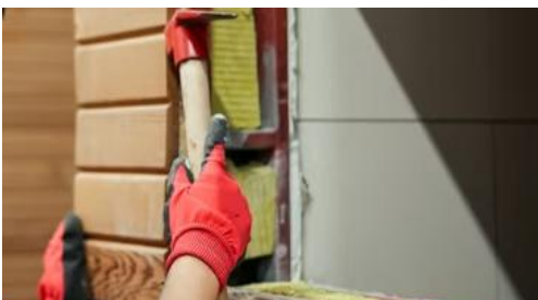
Pose d'un bardage de finition (source : source : © Unsplash)
