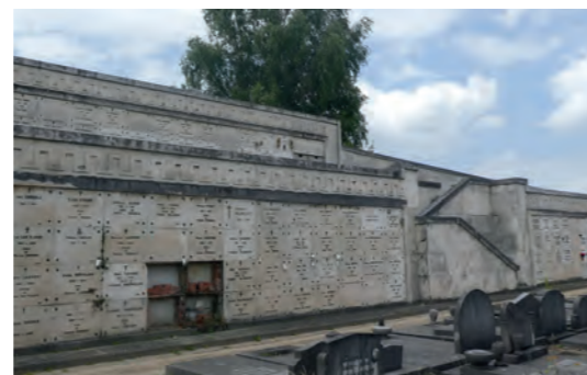
jaren 1950 - Galerijen aangelegd op twee niveaus
