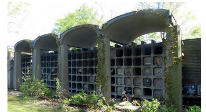
De columbaria van de Brusselse begraafplaats zijn volledig vervaardigd met gewapend beton met een gewassen afwerking en bestaan uit modulaire gestandaardiseerde elementen. Hun vorm is allesbehalve strak door de gebogen lijnen die zowel in de luifels als in de nissen terugkomen (echo).
